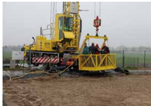
Abb. 20: Autokran am Rübenmusbecken des Betriebes Biogas Ralf Otten - Projektbeteiligte im Korb
